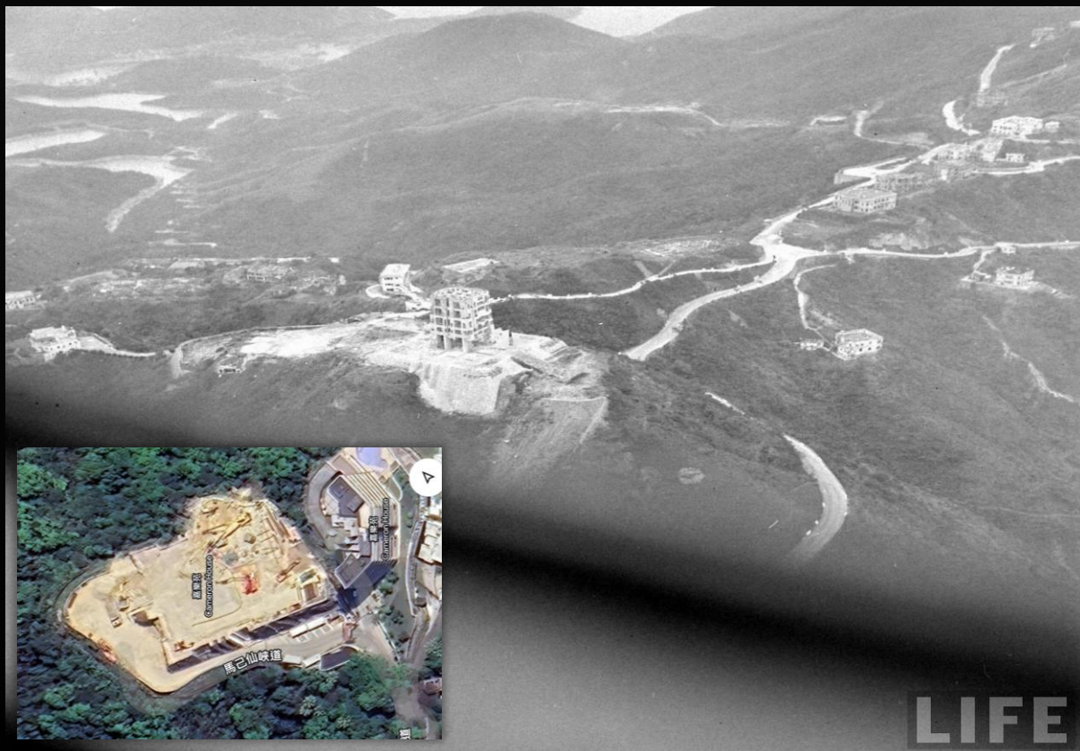
上圖:2025年6月金馬倫山上的忠靈塔的基座及1945年LIFE雜誌時的航空照片。 左下:金馬倫大廈4月開始進行拆卸工程到8月所有建築物已經完全拆除後,見到忠靈塔完整基座(Google衛星圖片)。 圖片來源:延陵科學綜合室
