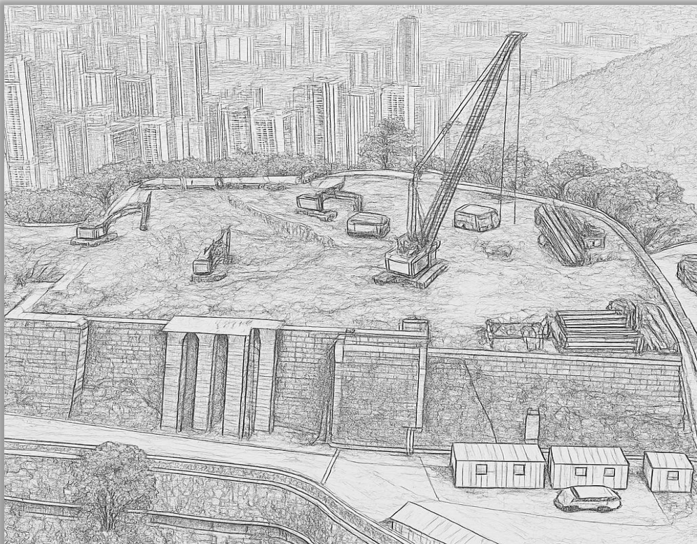
上圖：金馬倫山向西面方向 為忠靈塔基座的西側面 垂直「三間紋飾」完整清晰 靠右邊的一條間紋柱側 是拆卸電梯的痕跡基座上可見1950年代興建金馬倫大廈時 在右方加建的擴充性花崗岩石砌圍牆結構 圖片來源：延陵科學綜合室
