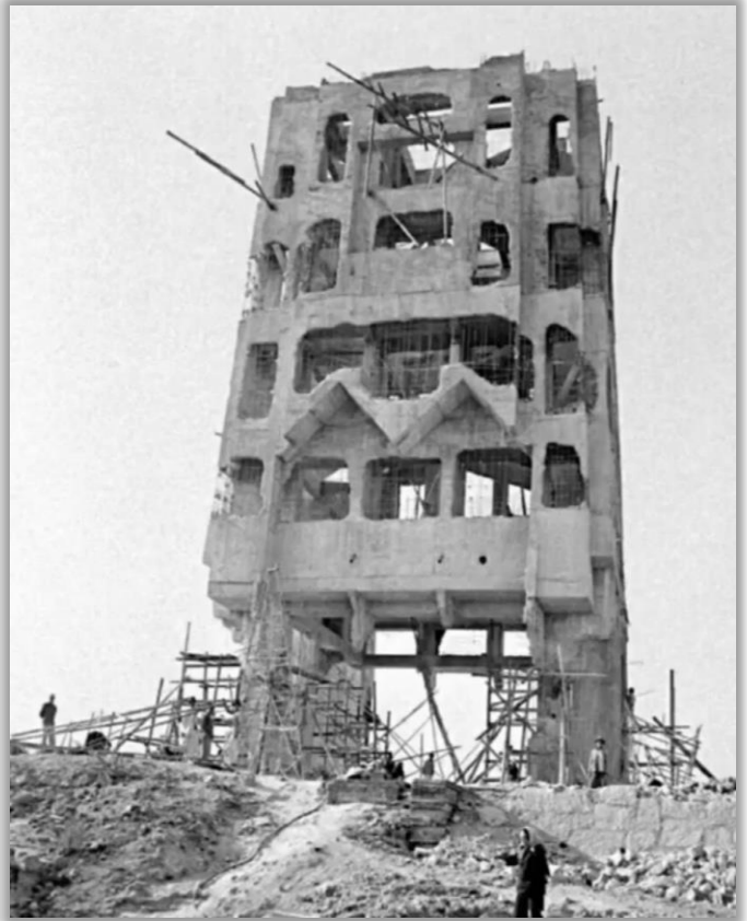
右圖 :拆卸忠靈塔「半塔」時需要工人先把塔內的水泥結構拆除
