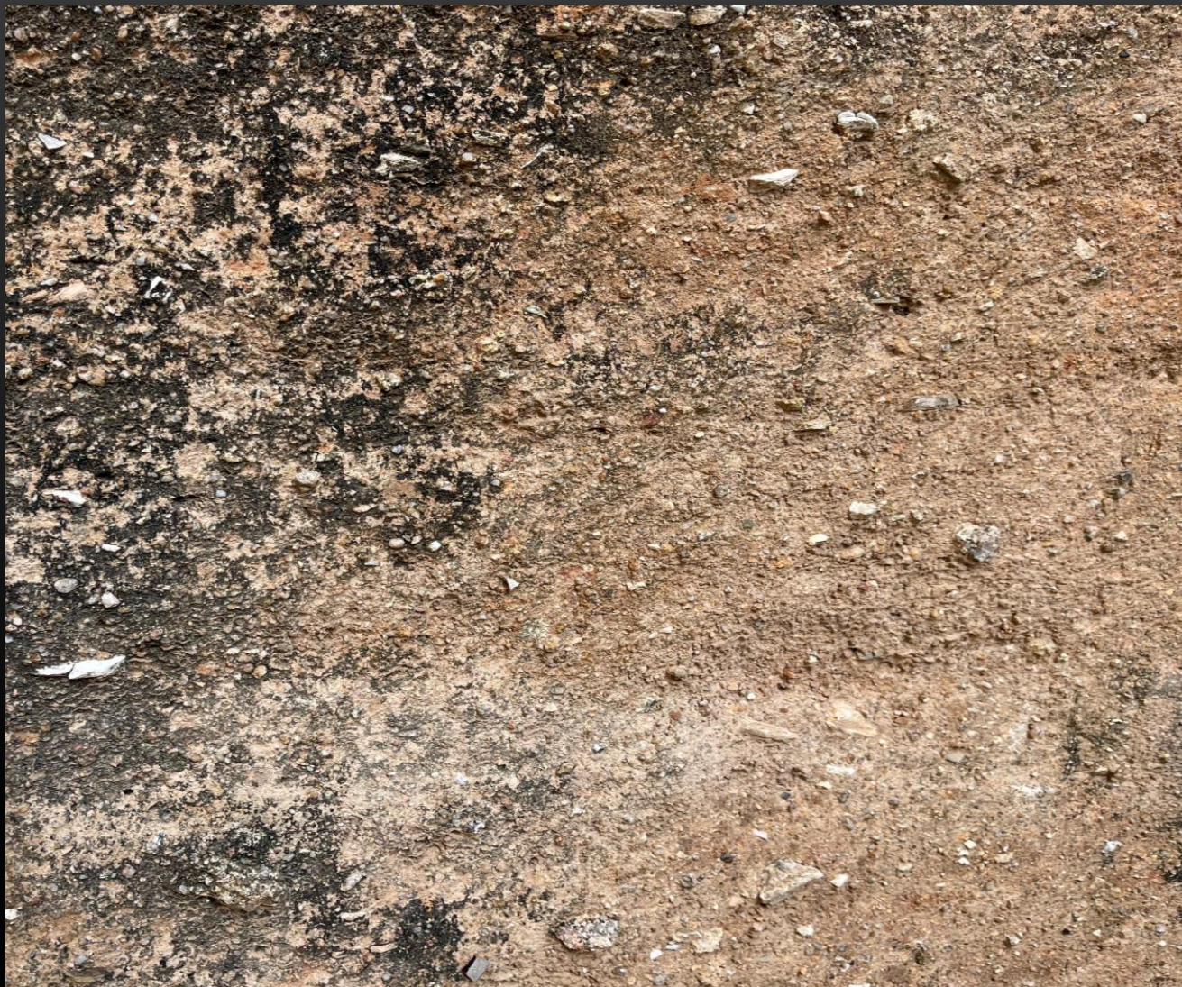
上圖：古城牆的夯土結構，磚石結合，蠔殼粉為當地海洋資源加工而成。 圖片來源：延陵科學綜合室檔案
