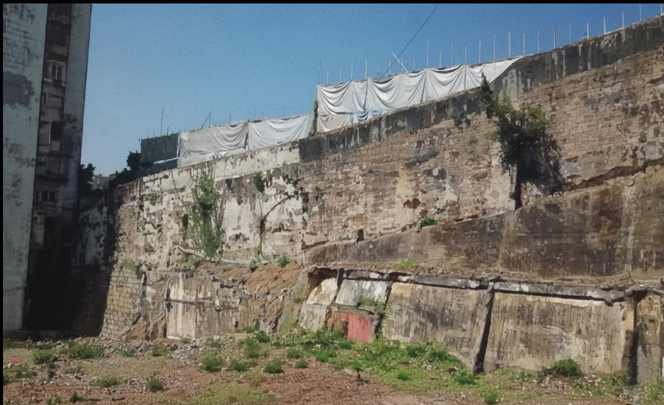
上圖：加思欄馬路一斜坡發生山泥傾瀉，導致鄰近具有逾四百年歷史、全長約50米的古城牆倒塌約18米。事後公共建設局以「危險」為由再拆除約10米城牆。圖片來源：延陵科學綜合室檔案
